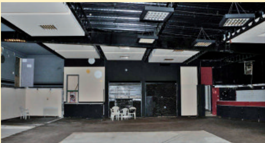
Zdewastowana sala przed remontem
